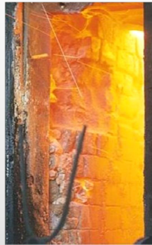
Perforacja warstw 1- 4 w jednym kanale grzewczym w części głowicowej
