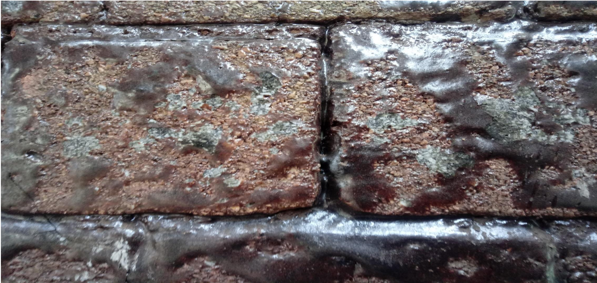
Widok fazy szklistej z przestrzeni podsklepieniowej komory
