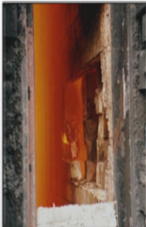
Wyłamanie ściany grzewczej o znacznej wysokości na kilku Kanałach grzewczych
