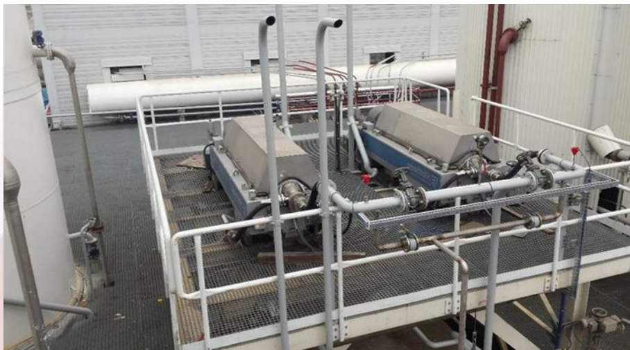
Zabudowa wirówki w instalacji oczyszczania wody amoniakalnej ze smoły
