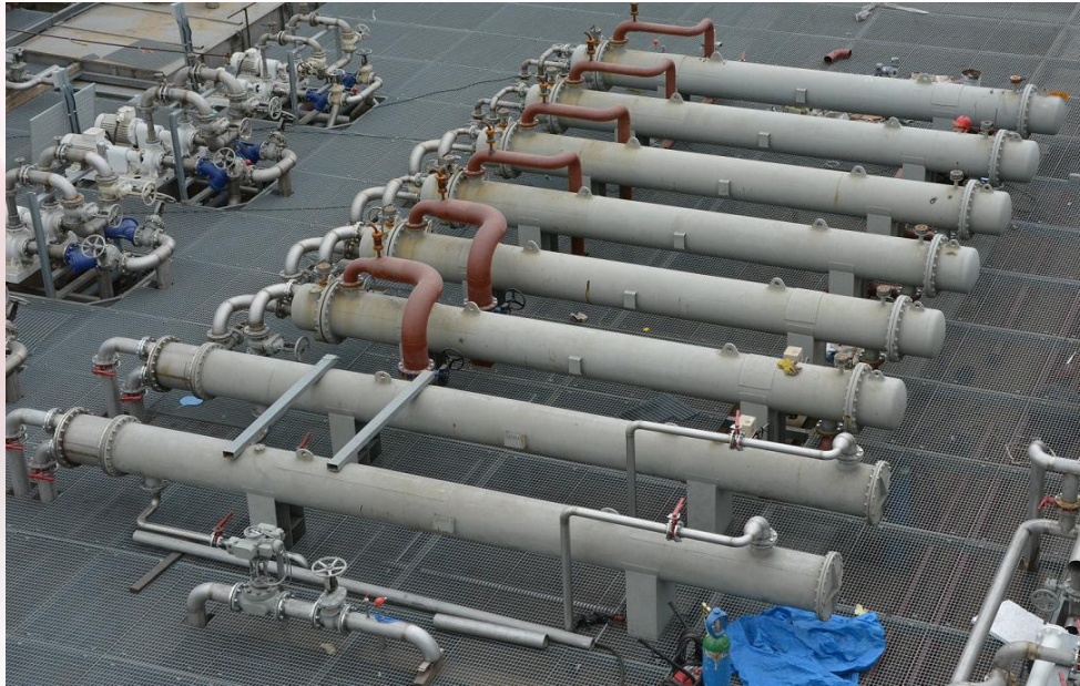
Wymiennik rurowy dwuprzepływowy Projekt własny HPH HUTMASZPROJEKT
